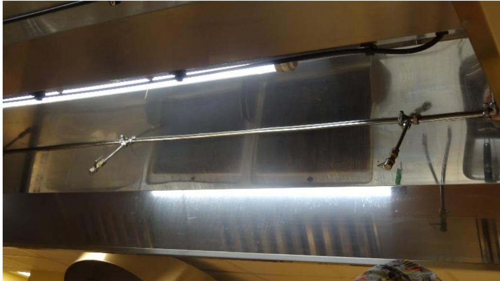
Detección térmica continua mediante tubo Easydetect
