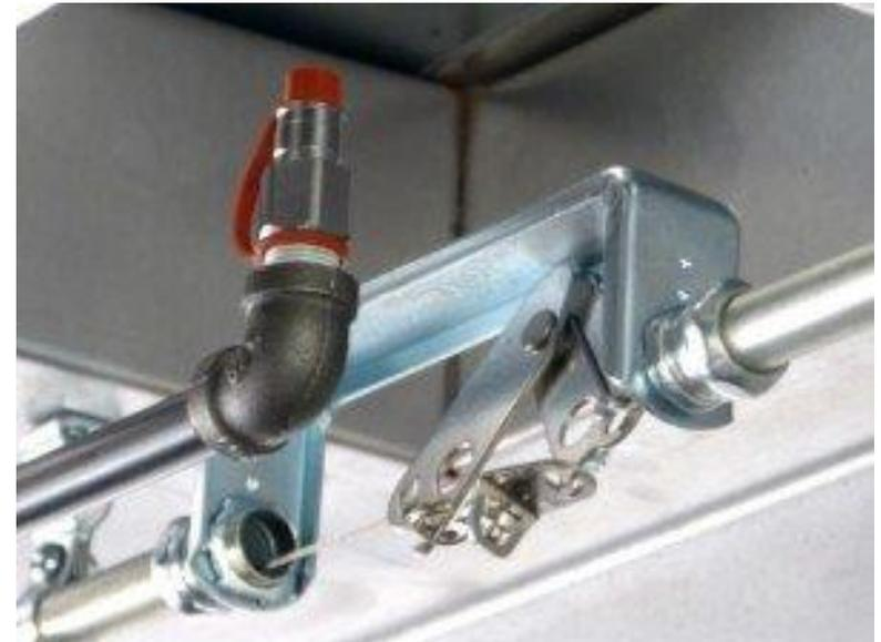
Detección térmica puntual mediante termofusible
