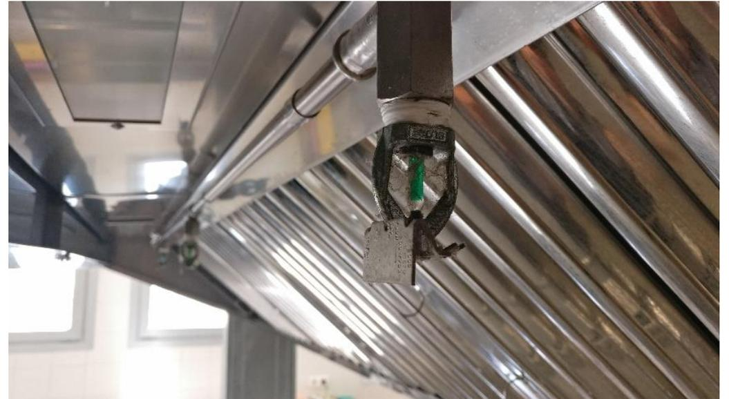
Detección térmica puntual mediante rociador
