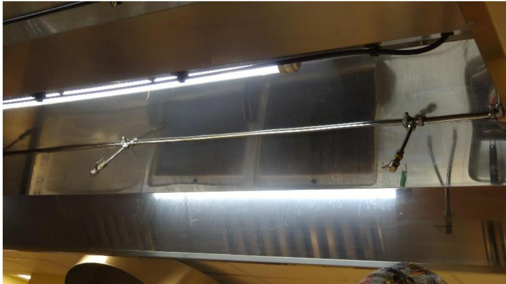
Detección térmica continua mediante tubo Easydetect
